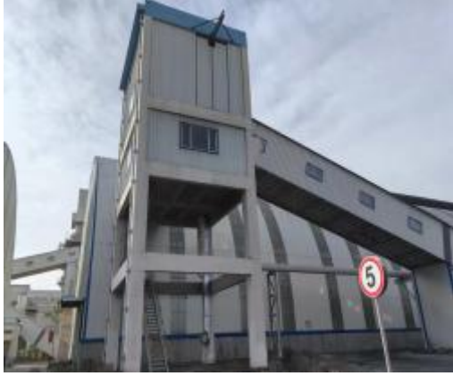
兰炭卸料转运站
